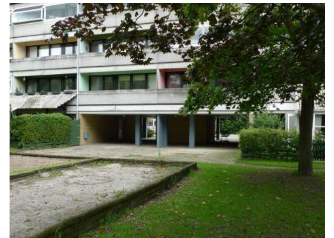
Passage under blok F virker ikke imødekomende, som en åbning til et grønt areal burde gøre
