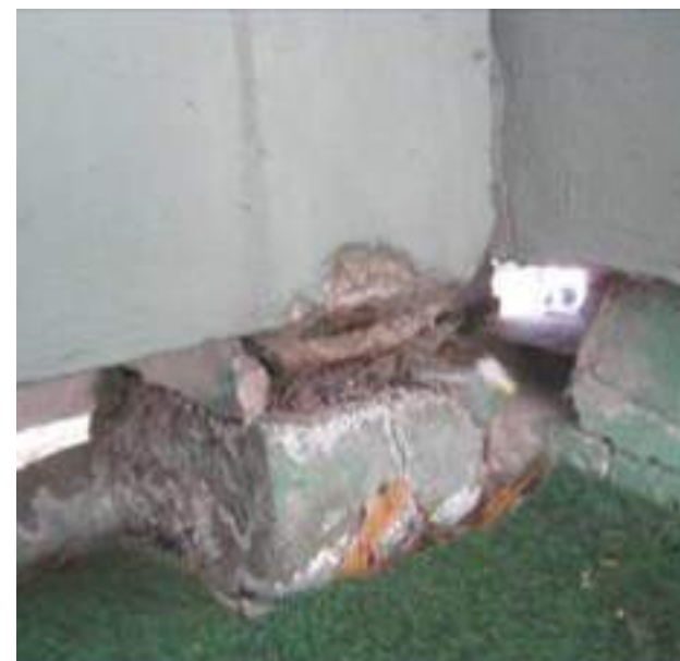
Eksempler på defekte understøbninger.
