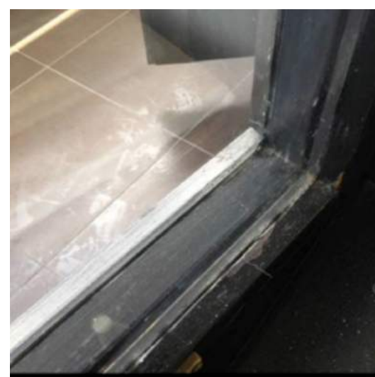
Vindueselement mod gårdside i blok F.
