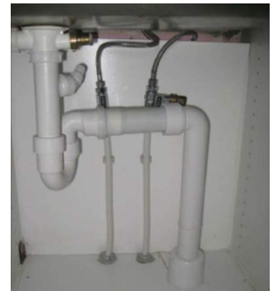
Ny afløbsinstallation tilsluttet køkkenvasken.
